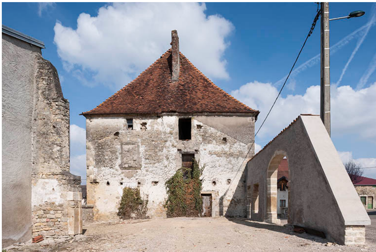
Mur pignon sud.
