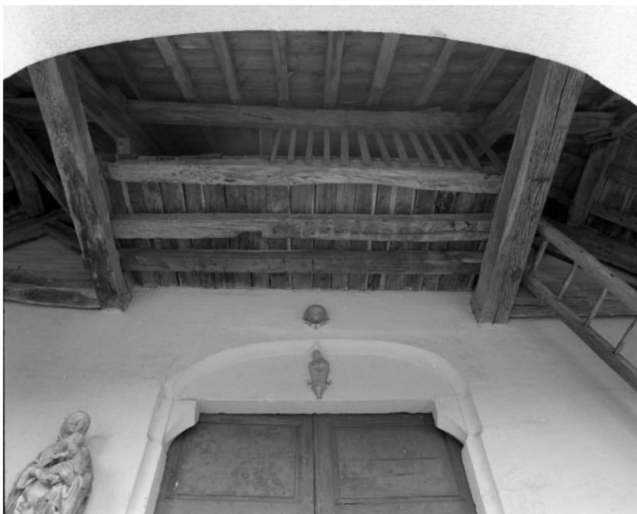
Porche, galerie permettant l'accès au clocher.
