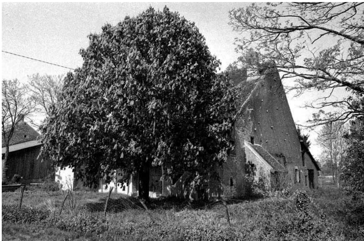
Façade latérale droite.
