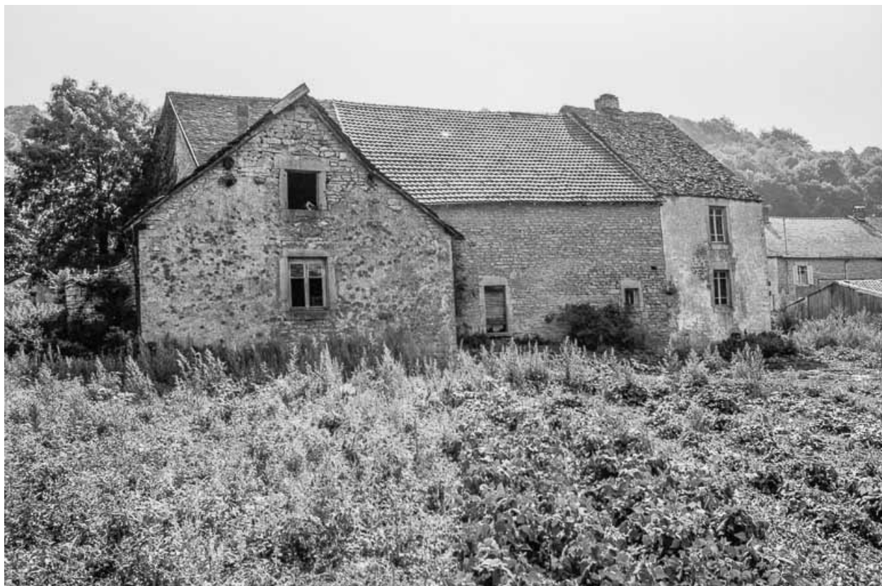
Ferme cadastrée ZK 40 : façade postérieure.
