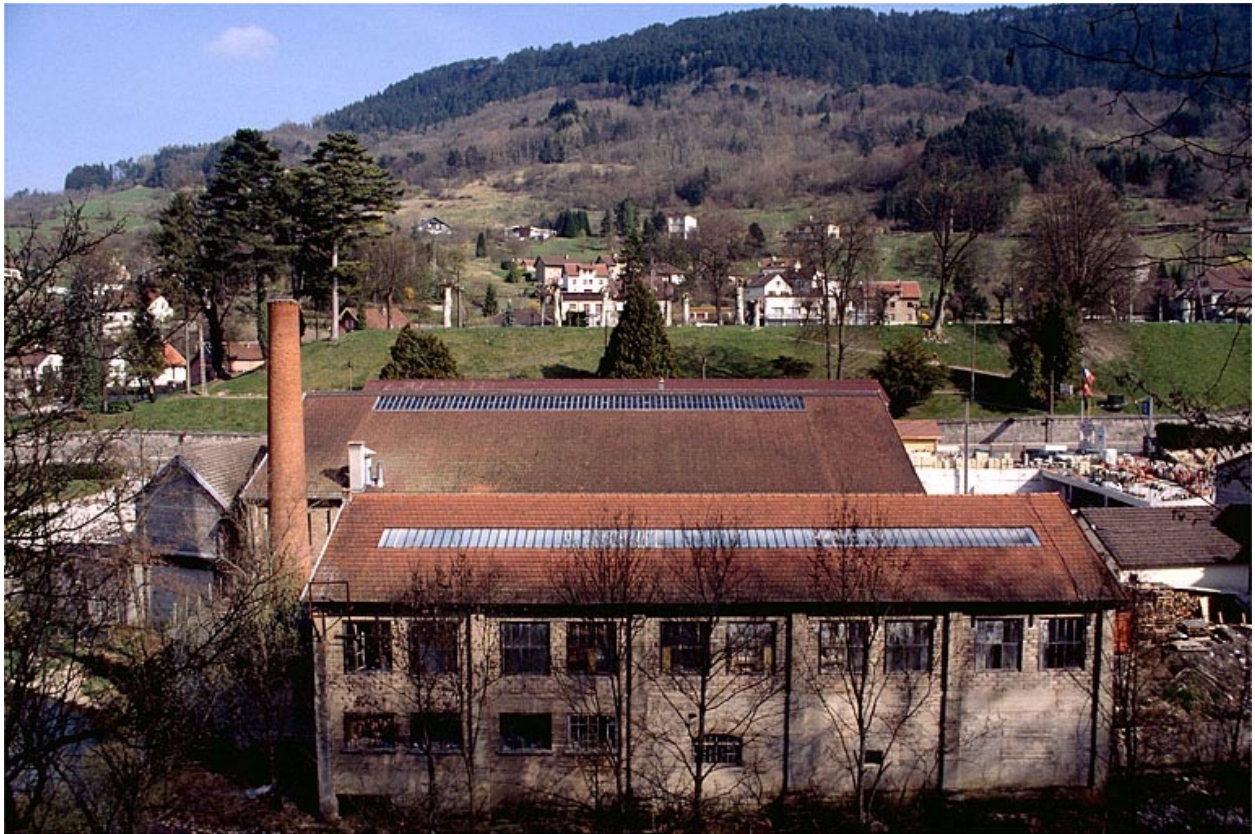
Façade postérieure de l'atelier de mécanique générale.
