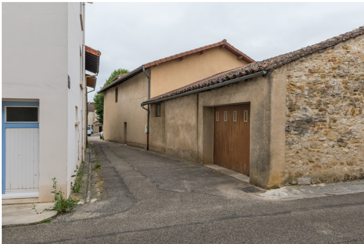
Façades postérieure et latérale droite.
