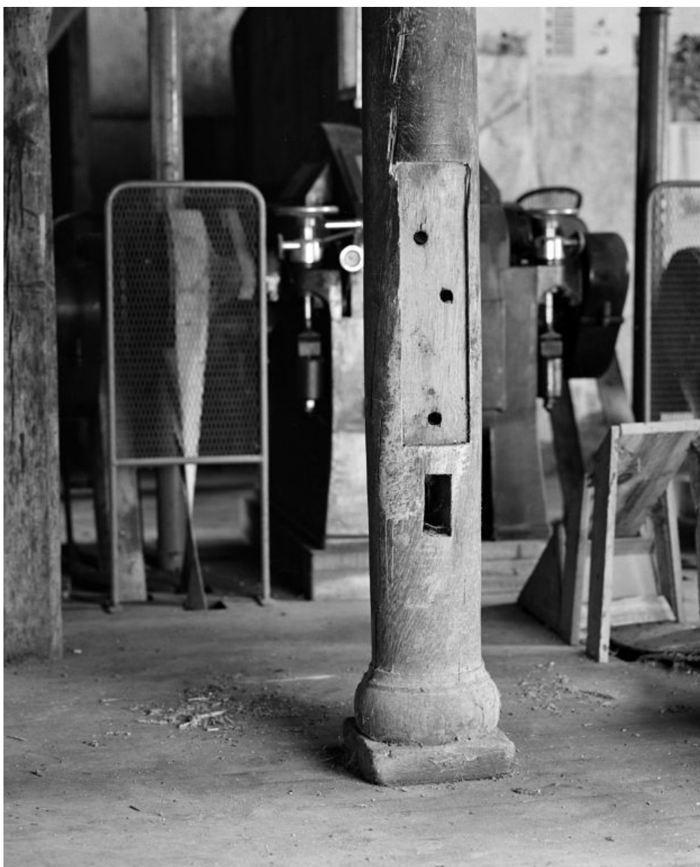
Rez-de-chaussée. Salle des machines, détail.
