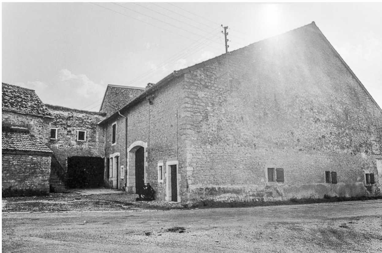
Ferme cadastrée A3 206 : façade antérieure.
