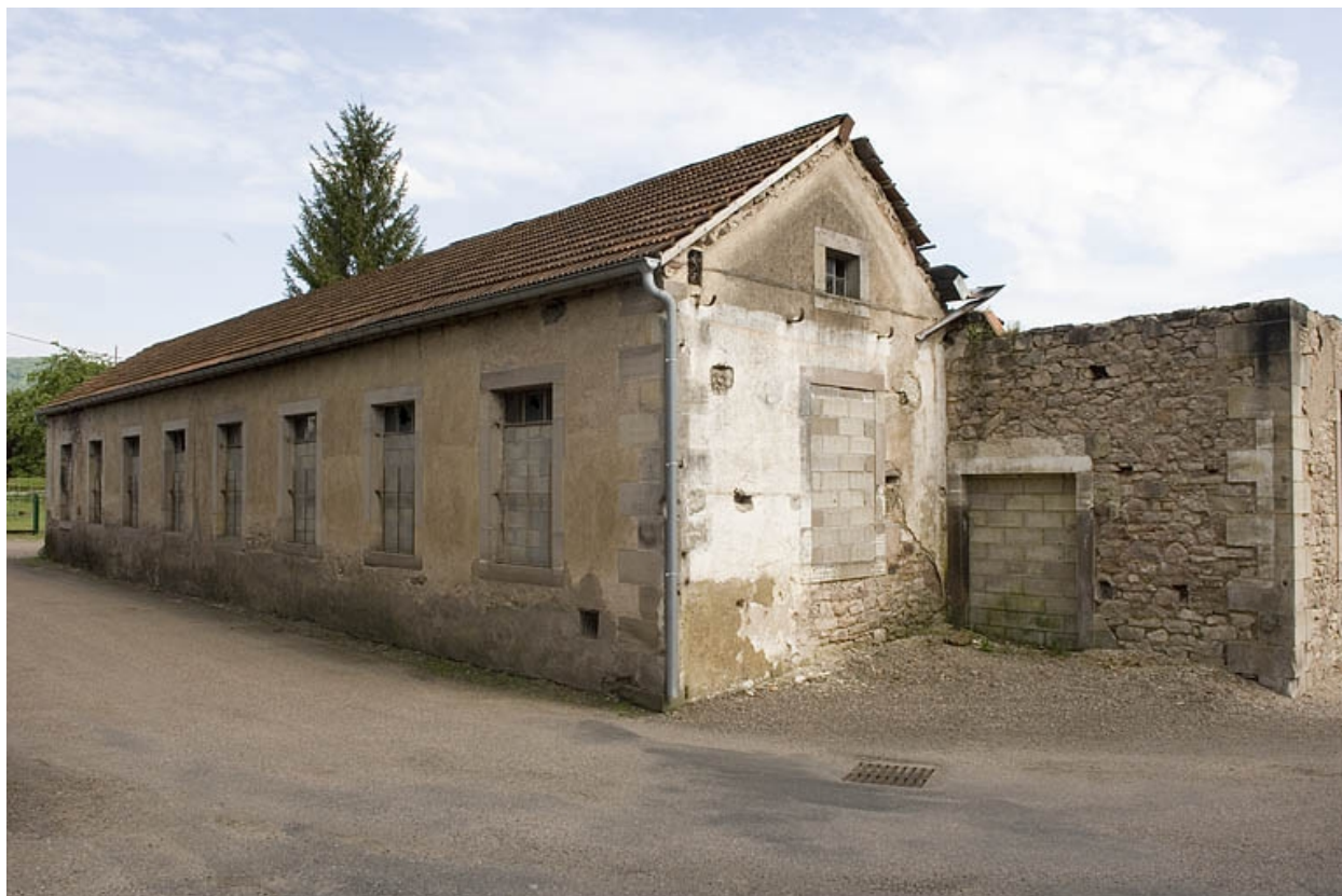
Façade nord de l'atelier de fabrication.
