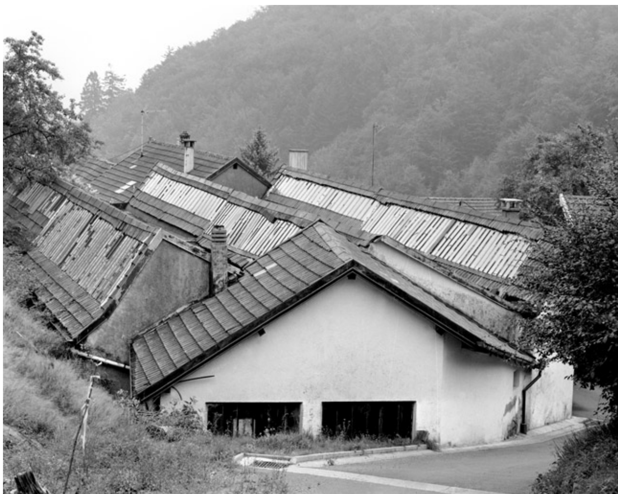
Sheds de l'atelier de fabrication depuis l'ouest.
