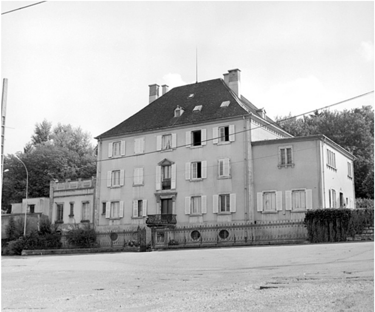
Façade sur rue en 1981.SRI. Enquête régionale sur les bâtiments industriels (1979-1981).
