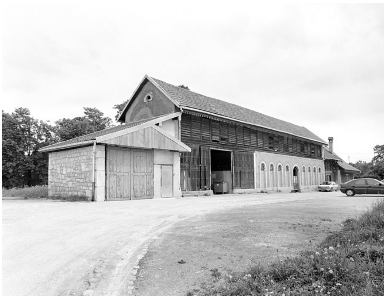
Vue de trois quarts de l'orangerie.
