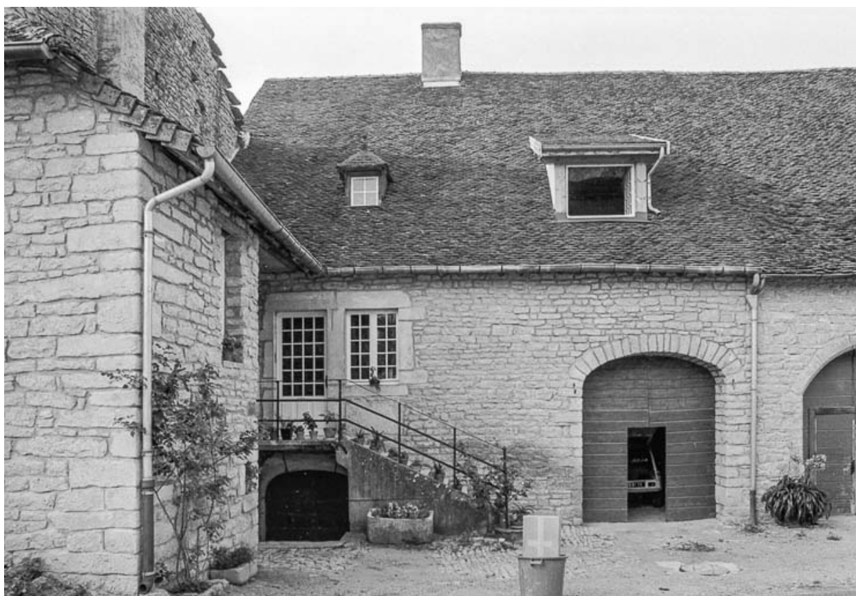
Ferme cadastrée AD 322 : façade antérieure.
