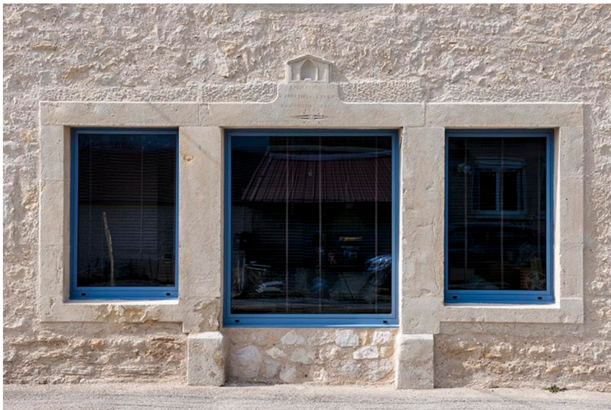
Ouvertures du mur-pignon est.
