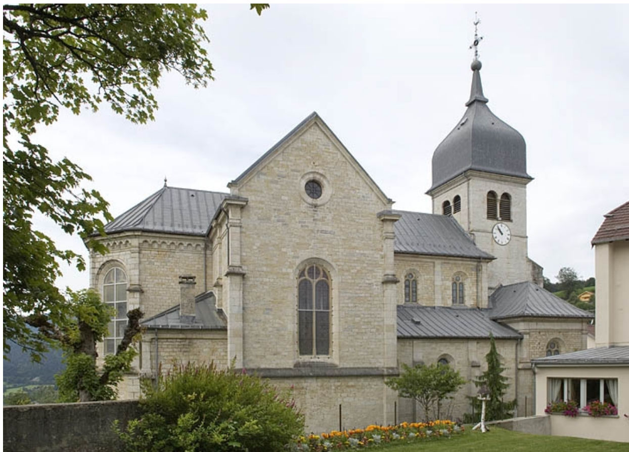
Façade latérale gauche.
