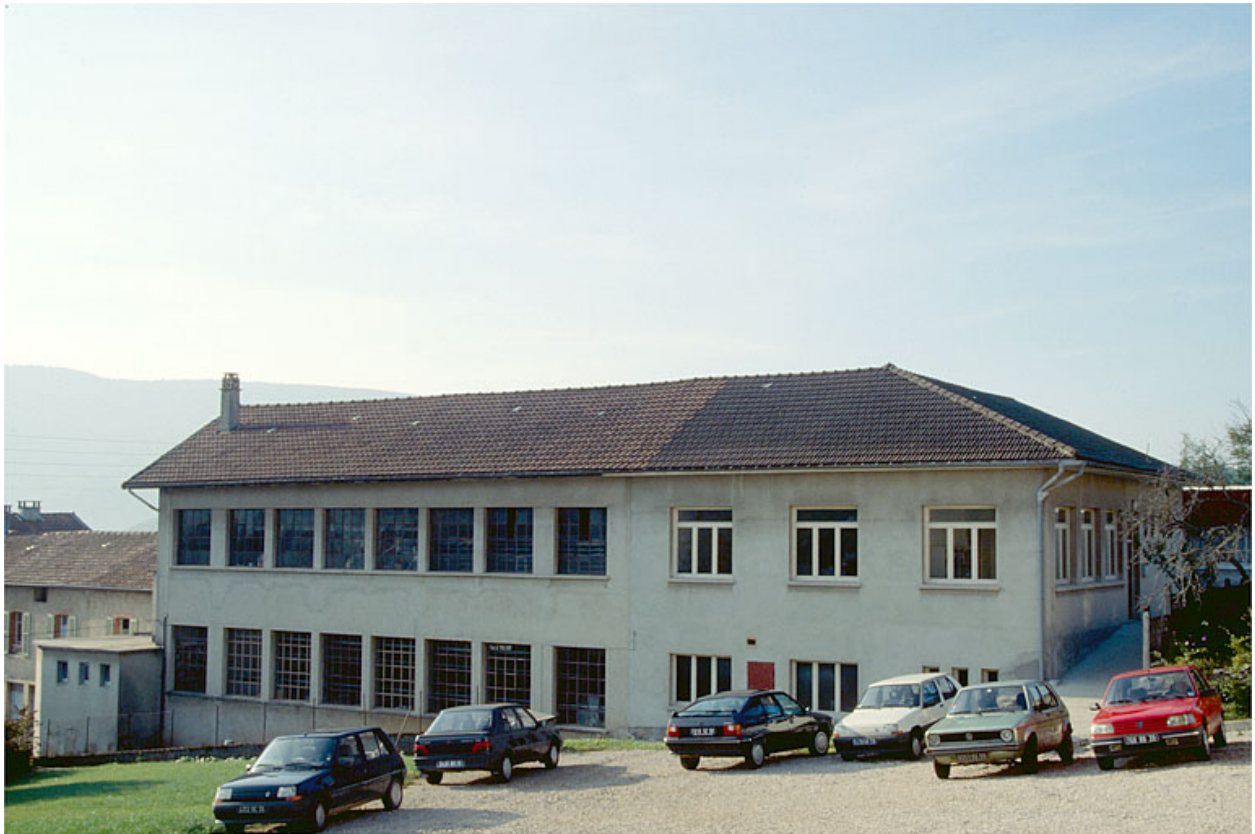
Atelier de fabrication (H), vu du nord-ouest.
