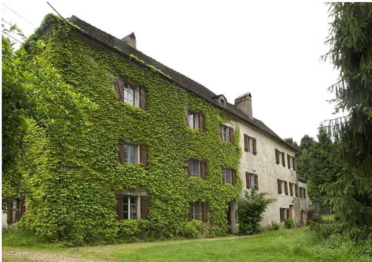
Logement patronal. Élévation ouest.
