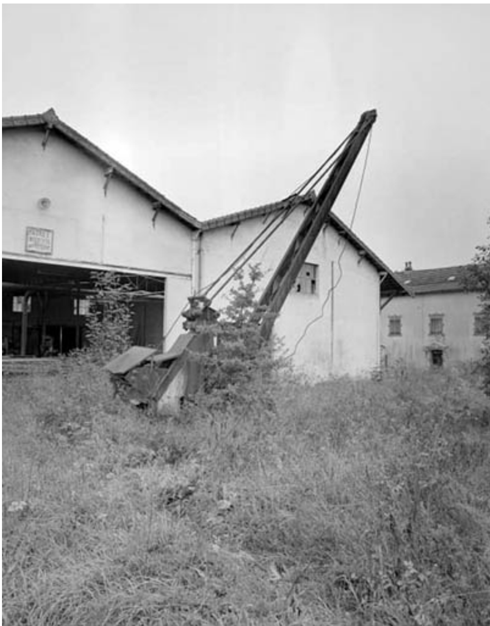
Grue sur l'aire des matières premières.
