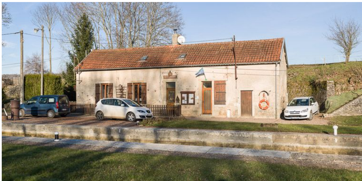
La maison éclusière vue de 3/4.
