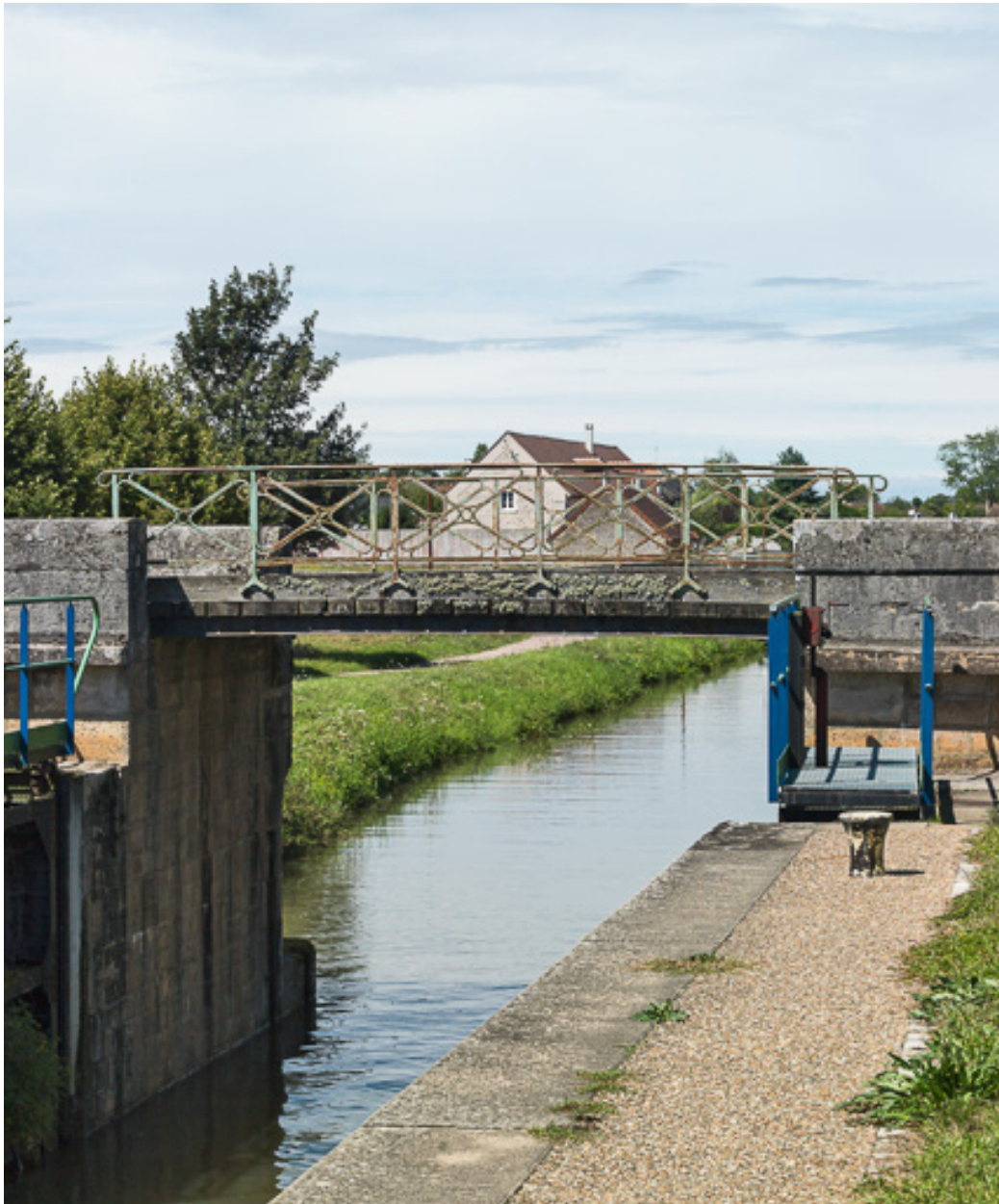
Vue du pont.
