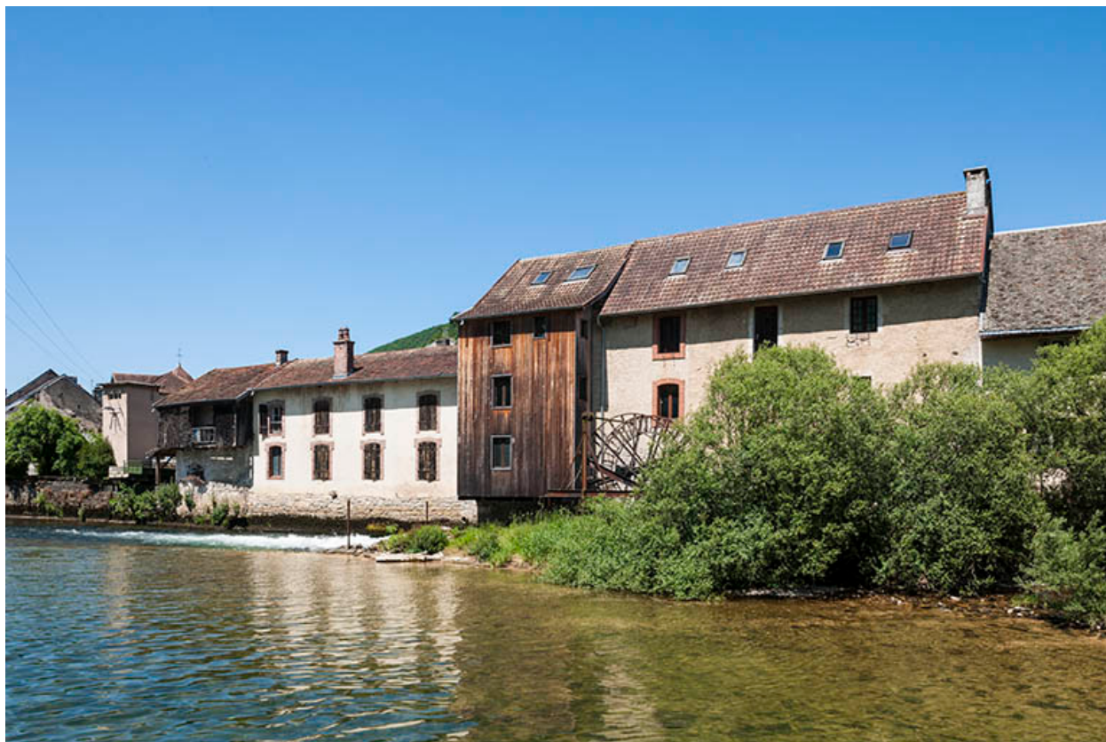
Vue d'ensemble depuis la rive droite.
