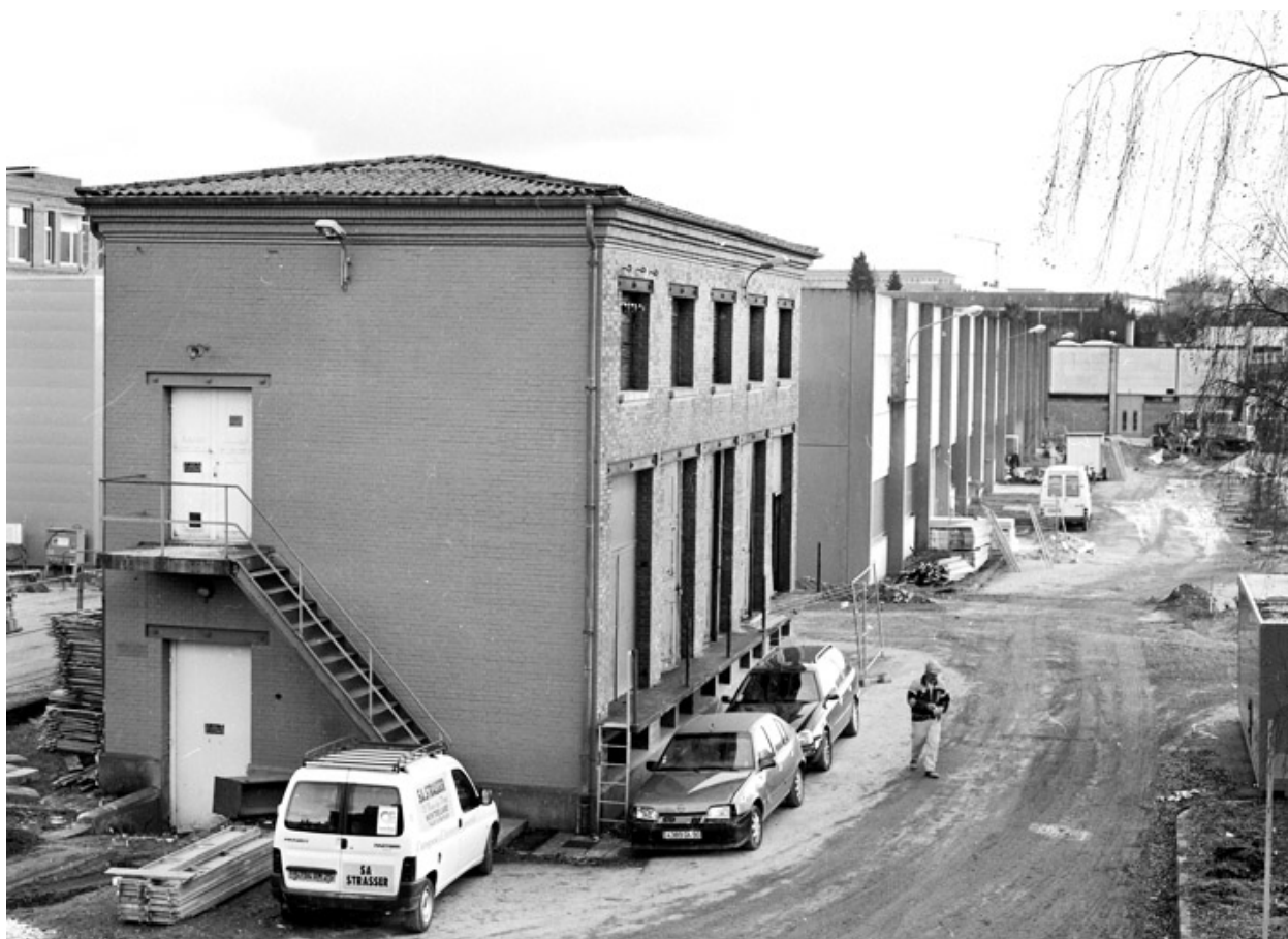
Transformateur : vue depuis l'atelier de filature.
