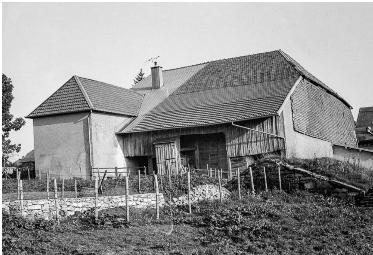
Ferme : façade postérieure.
