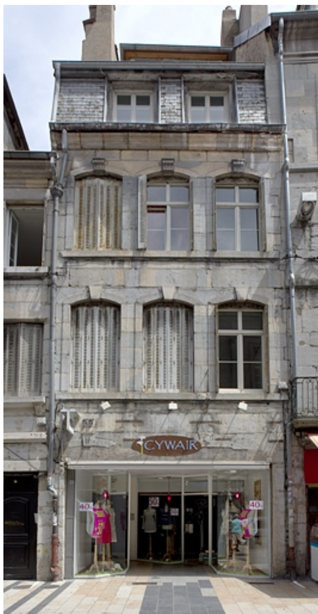
Logis principal, façade sur rue : de face.
