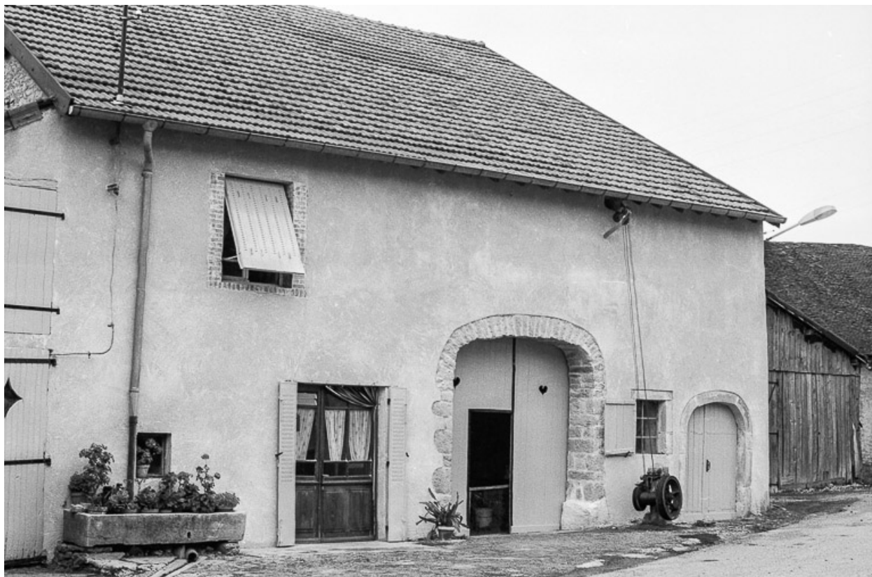
Ferme cadastrée B2 113 : façade antérieure.
