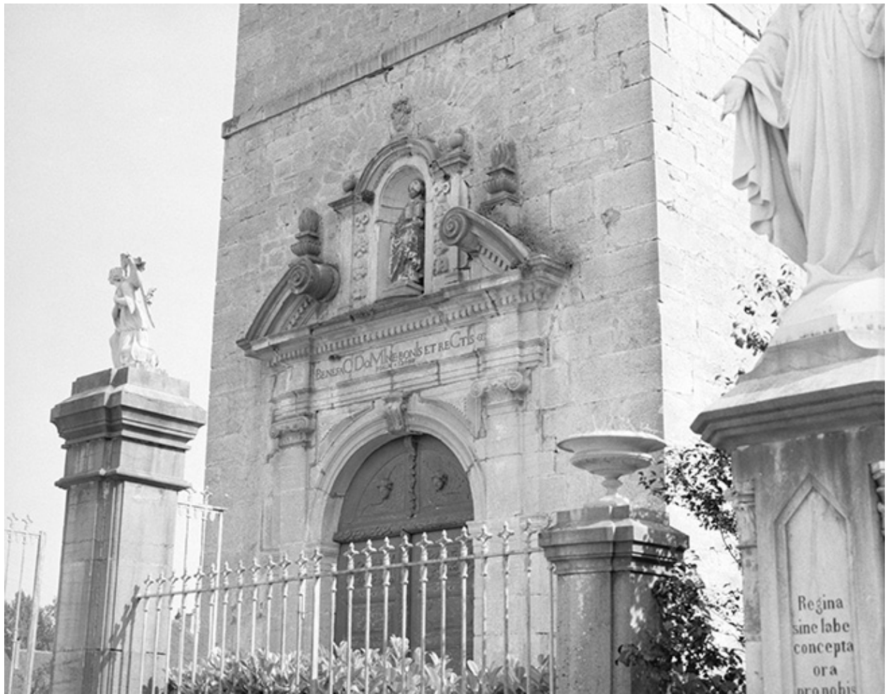
Façade antérieure, portail, partie supérieure.
