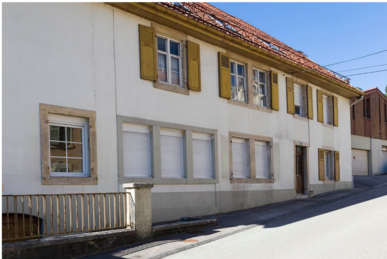
Ferme : façade antérieure, de trois quarts gauche.
