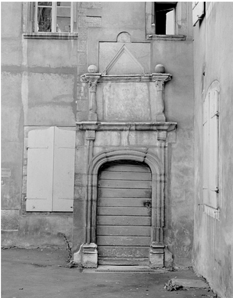
Porte de la tour d'escalier.
