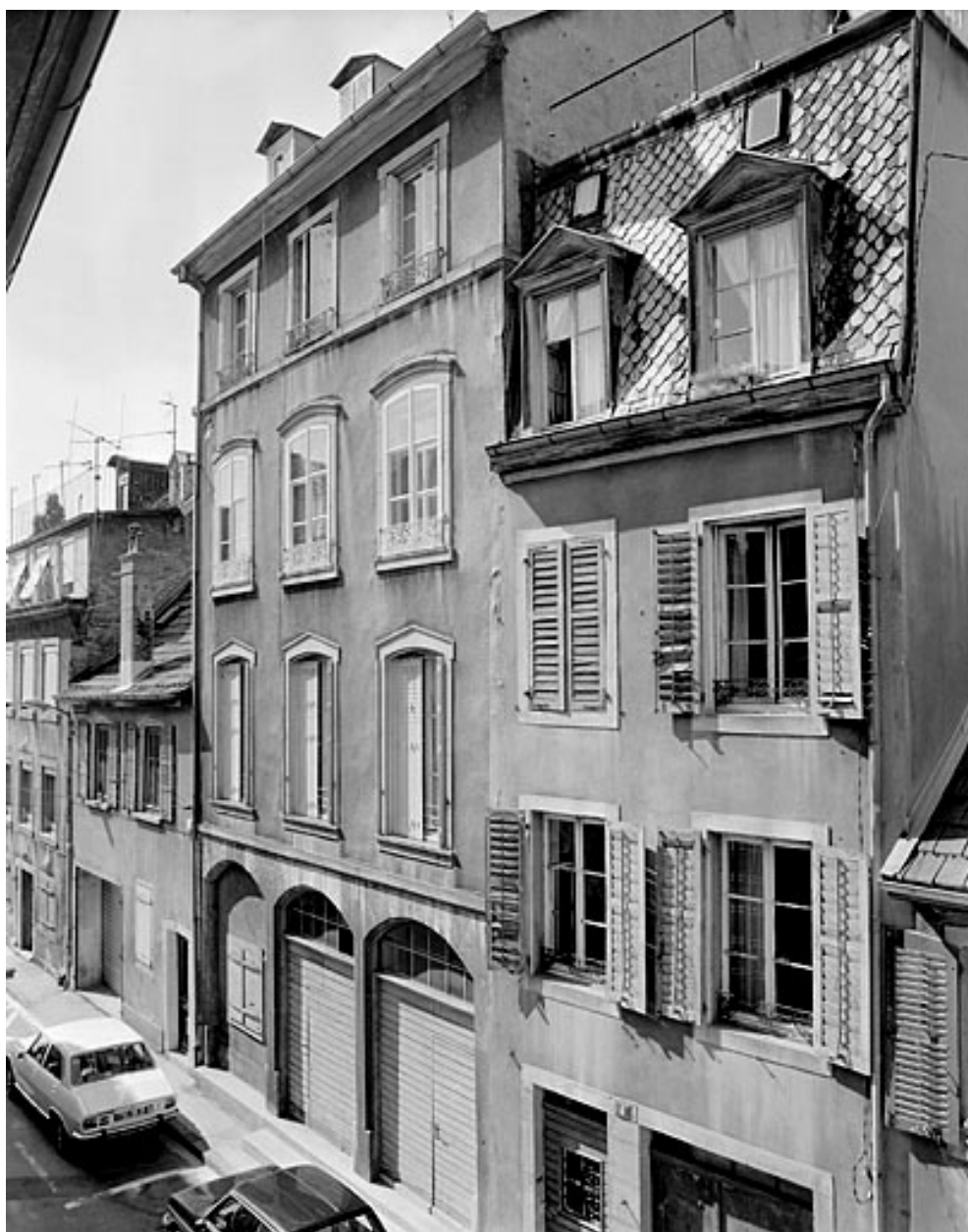
Façade sur la rue de la Planchette.
