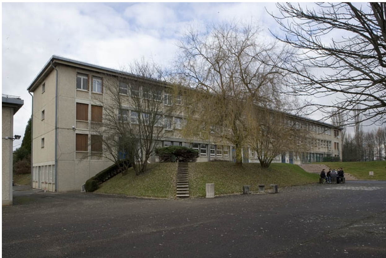
Vue façade antérieure bâtiment C.
