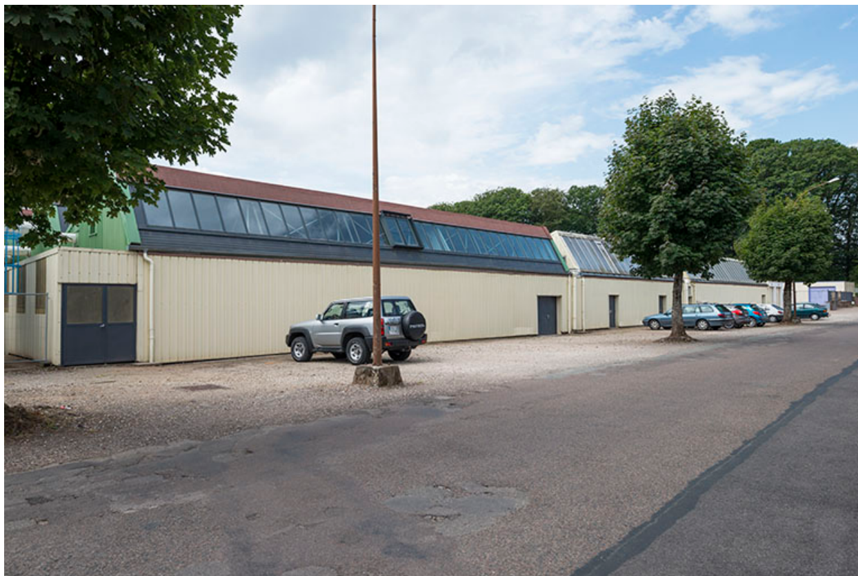
Ateliers : façade antérieure.
