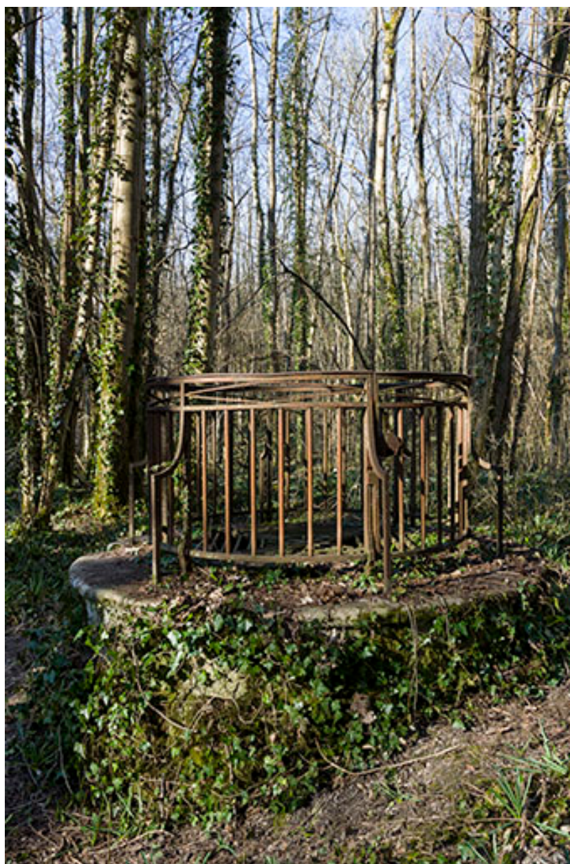
Puits d'aérage du tunnel.
