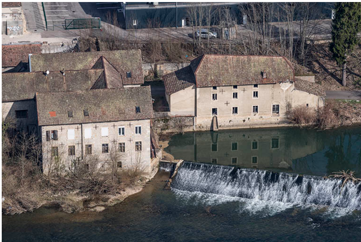
Vue plongeante rapprochée depuis le sud.
