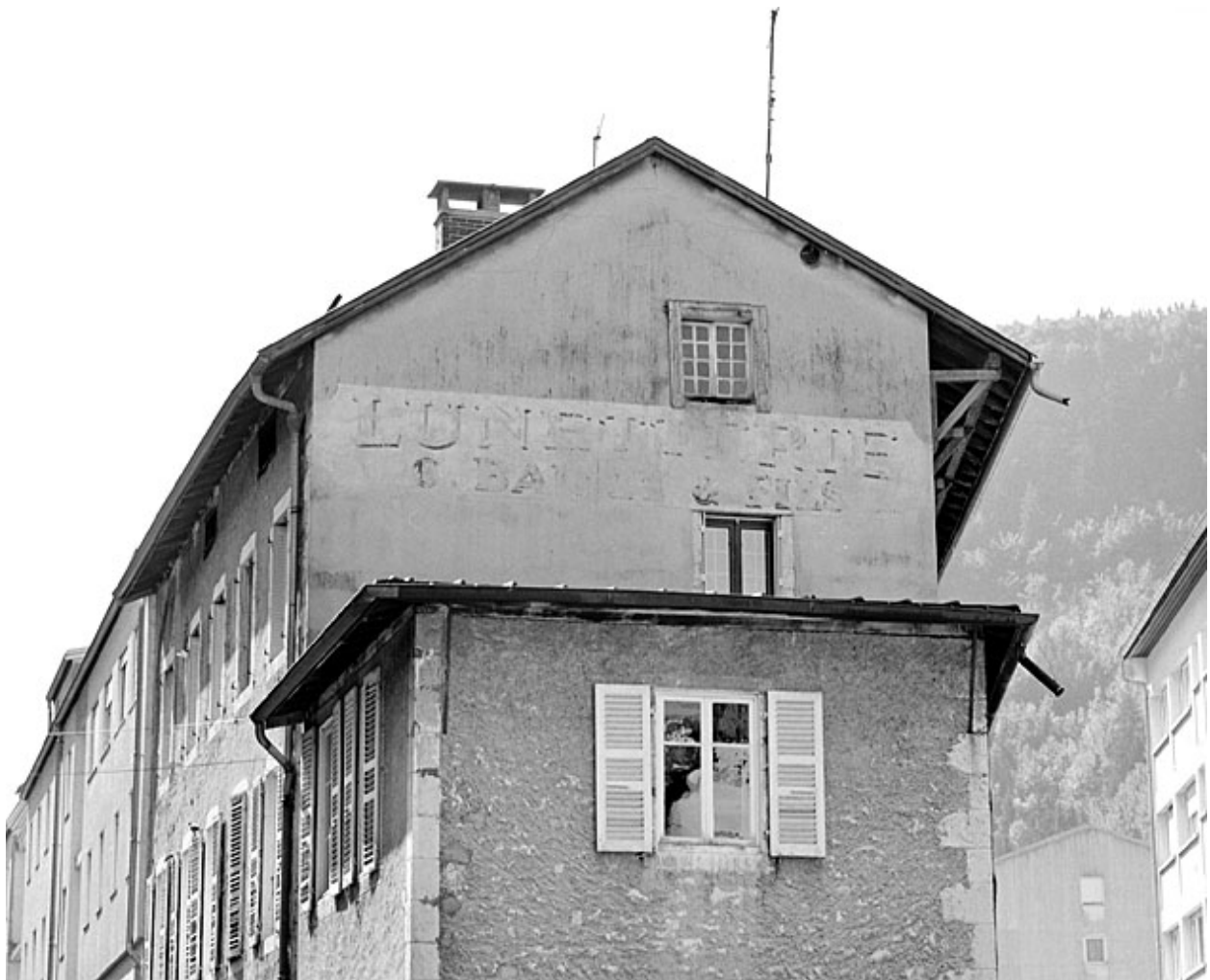
Inscription sur le mur pignon nord.
