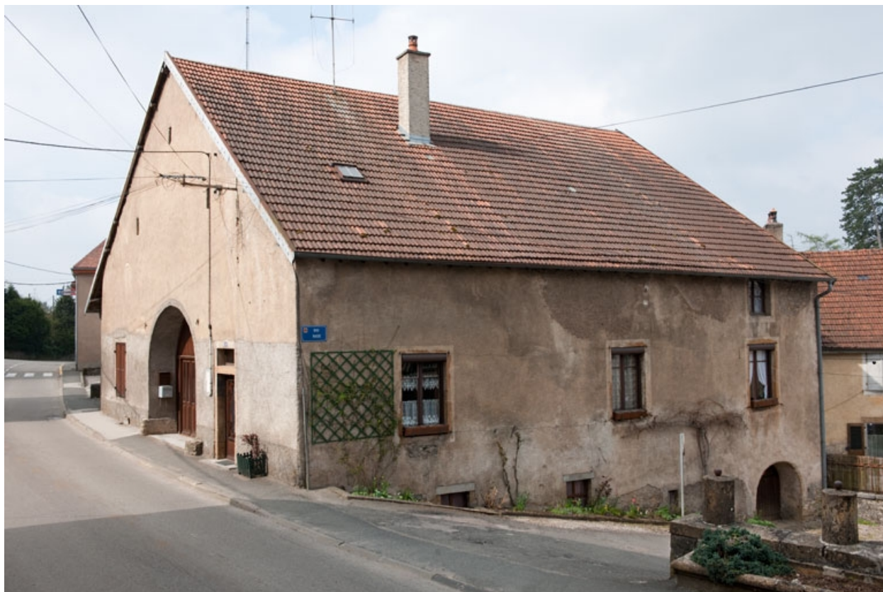
Façade antérieure et façade latérale droite.
