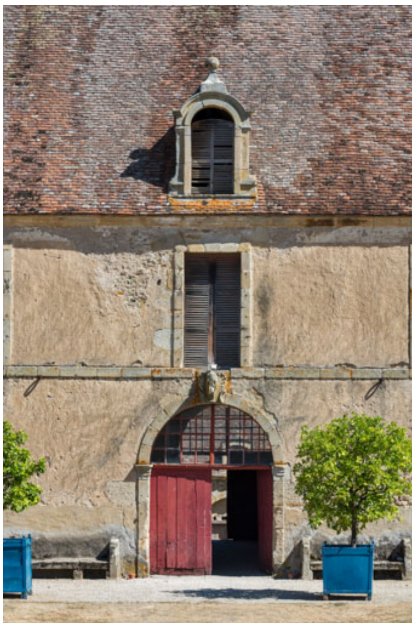
Façade antérieure : travée centrale.
