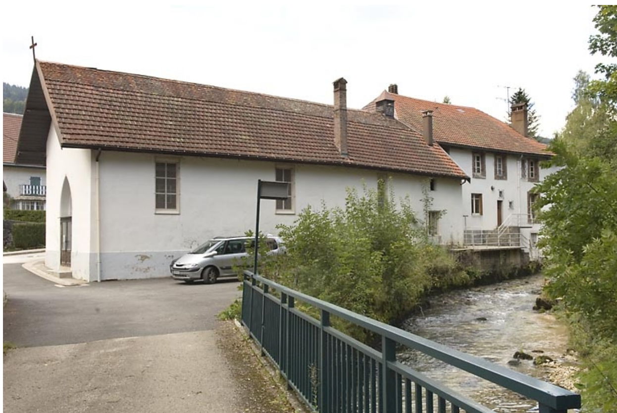
Chapelle rue des Forges : façade latérale droite.
