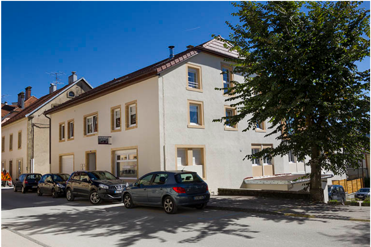
Façades antérieure et latérale droite.
