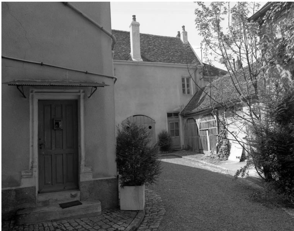
Logement sur cour et bûcher.
