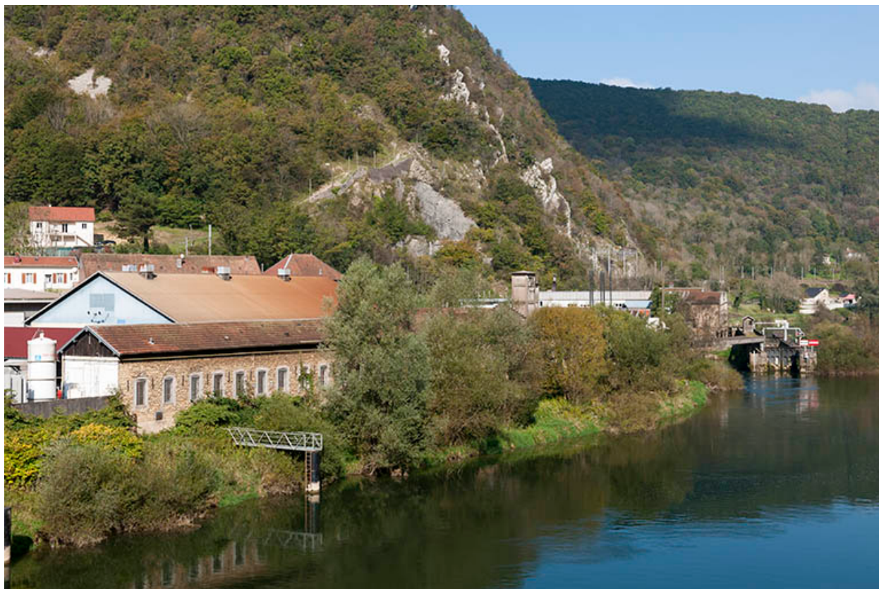
Vue rapprochée depuis le pont.
