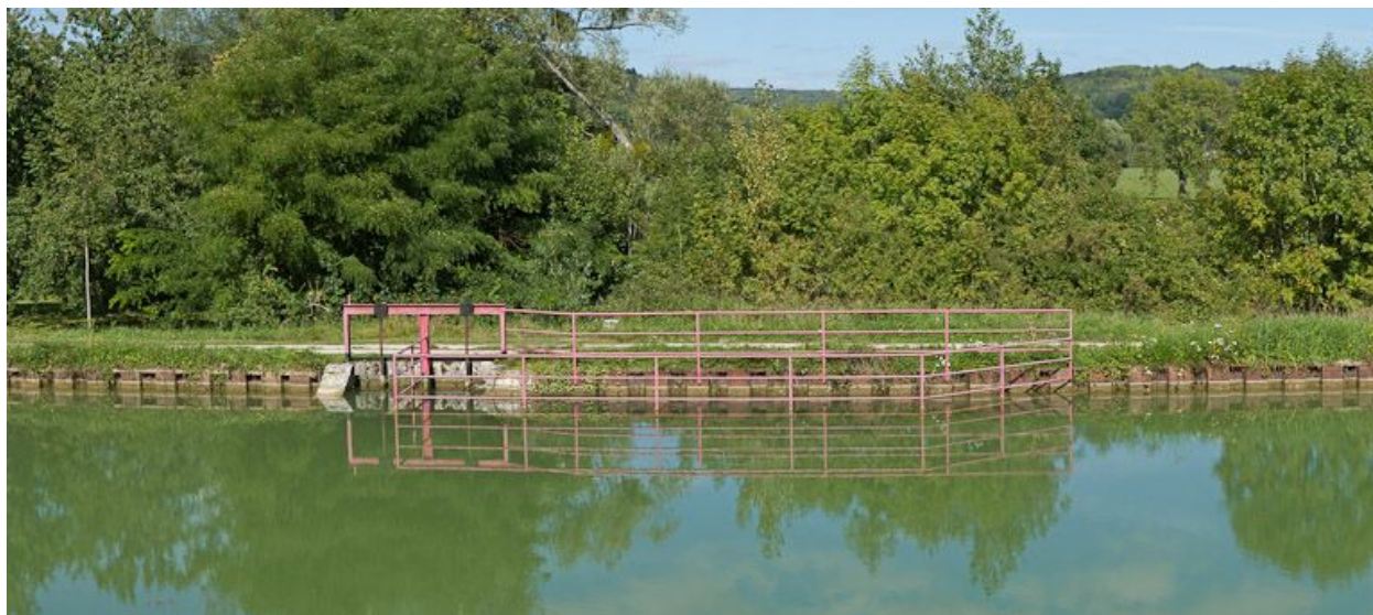
Vue du déversoir depuis la rive opposée.
