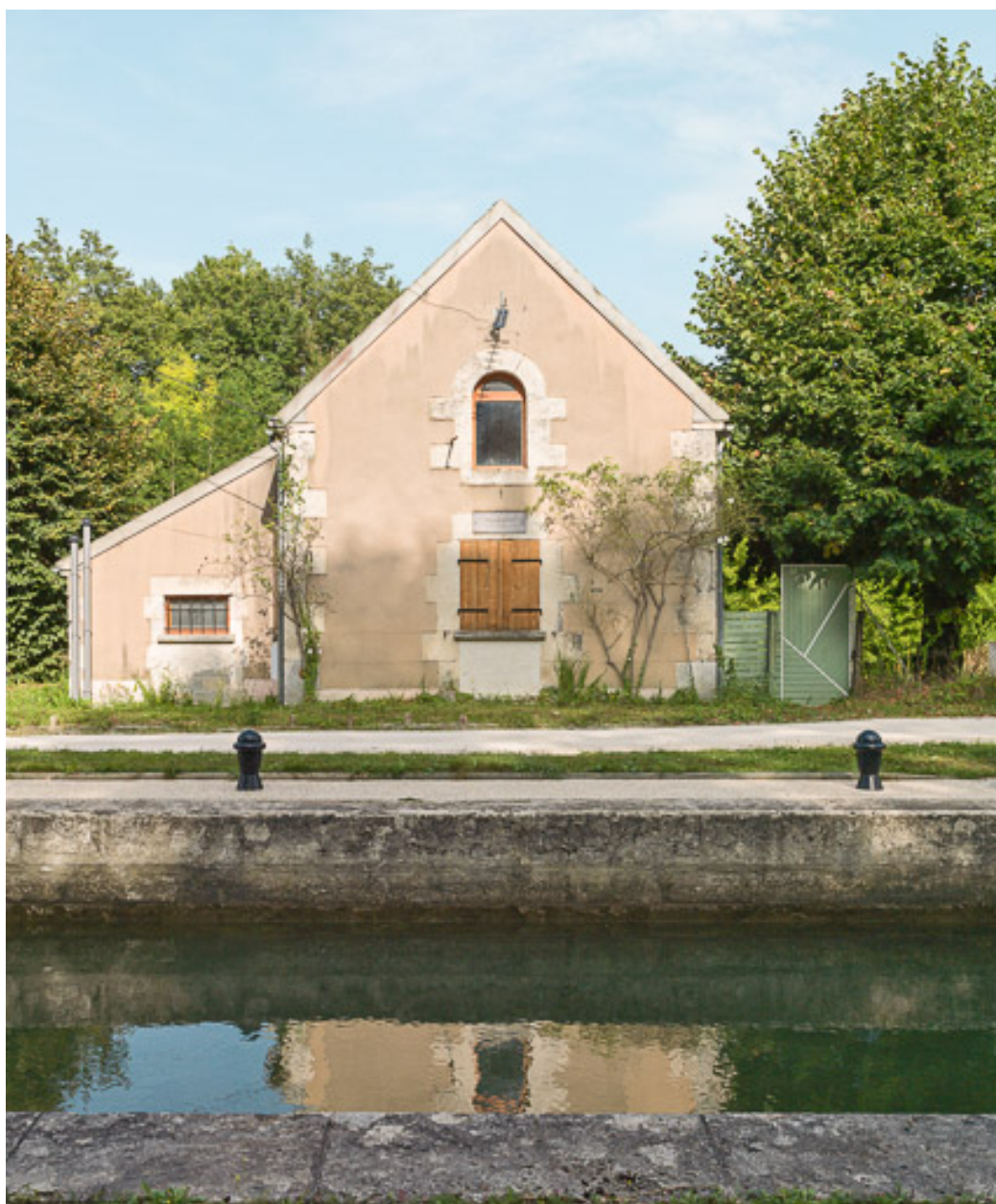
Vue de la maison éclusière.
