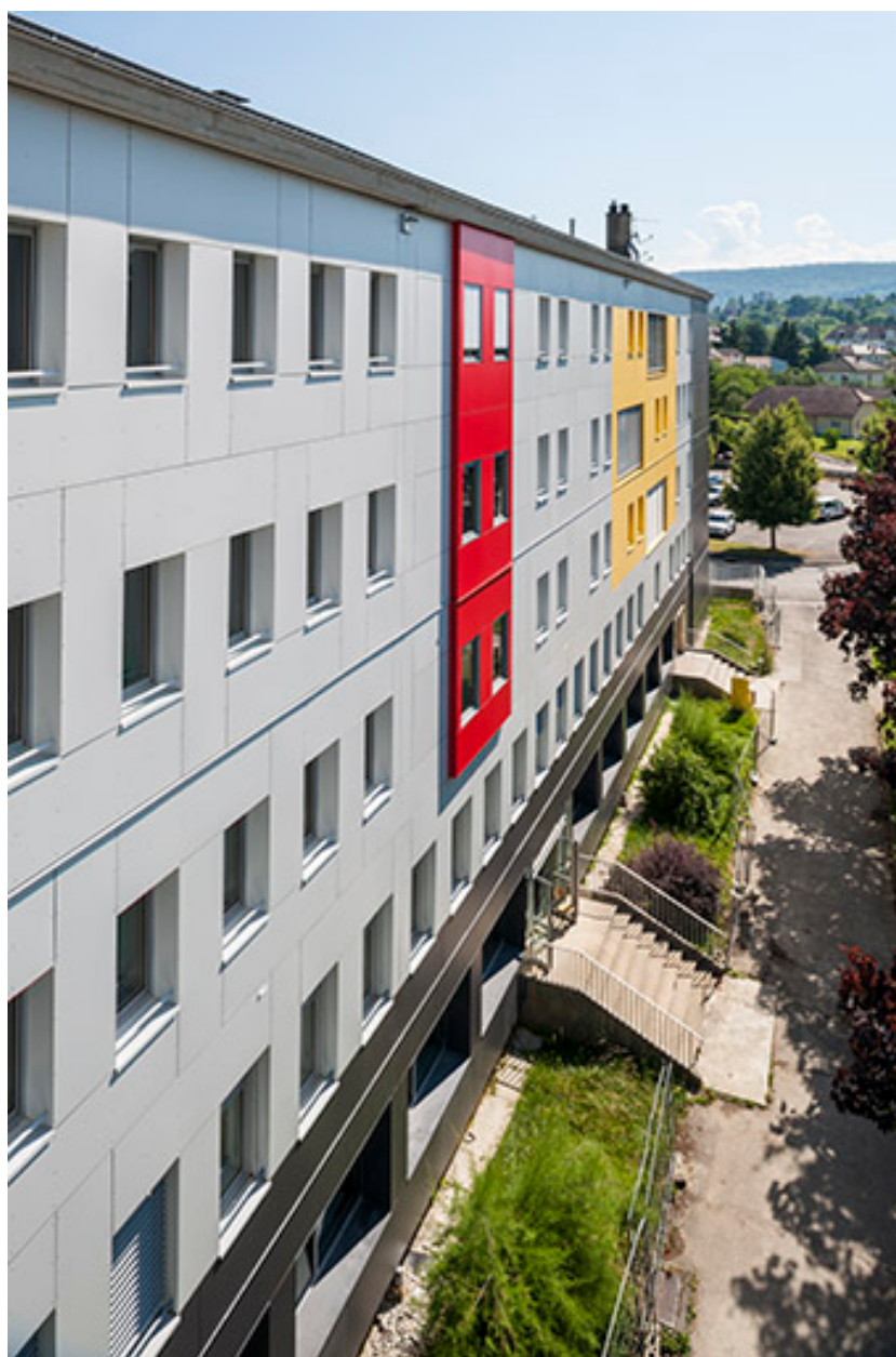
Façade antérieure de l'internat rénovée avec parement isolant.
