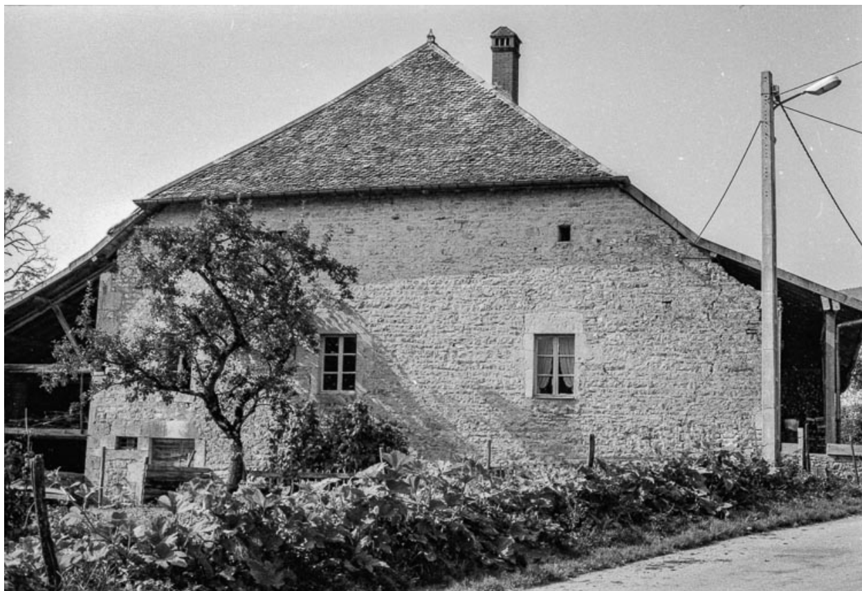
Ferme cadastrée 1961 AC 31 : façade latérale gauche.
