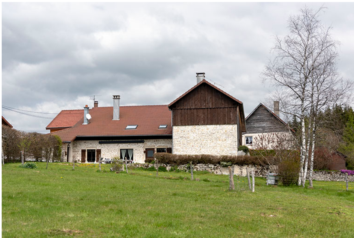
Façade latérale droite.
