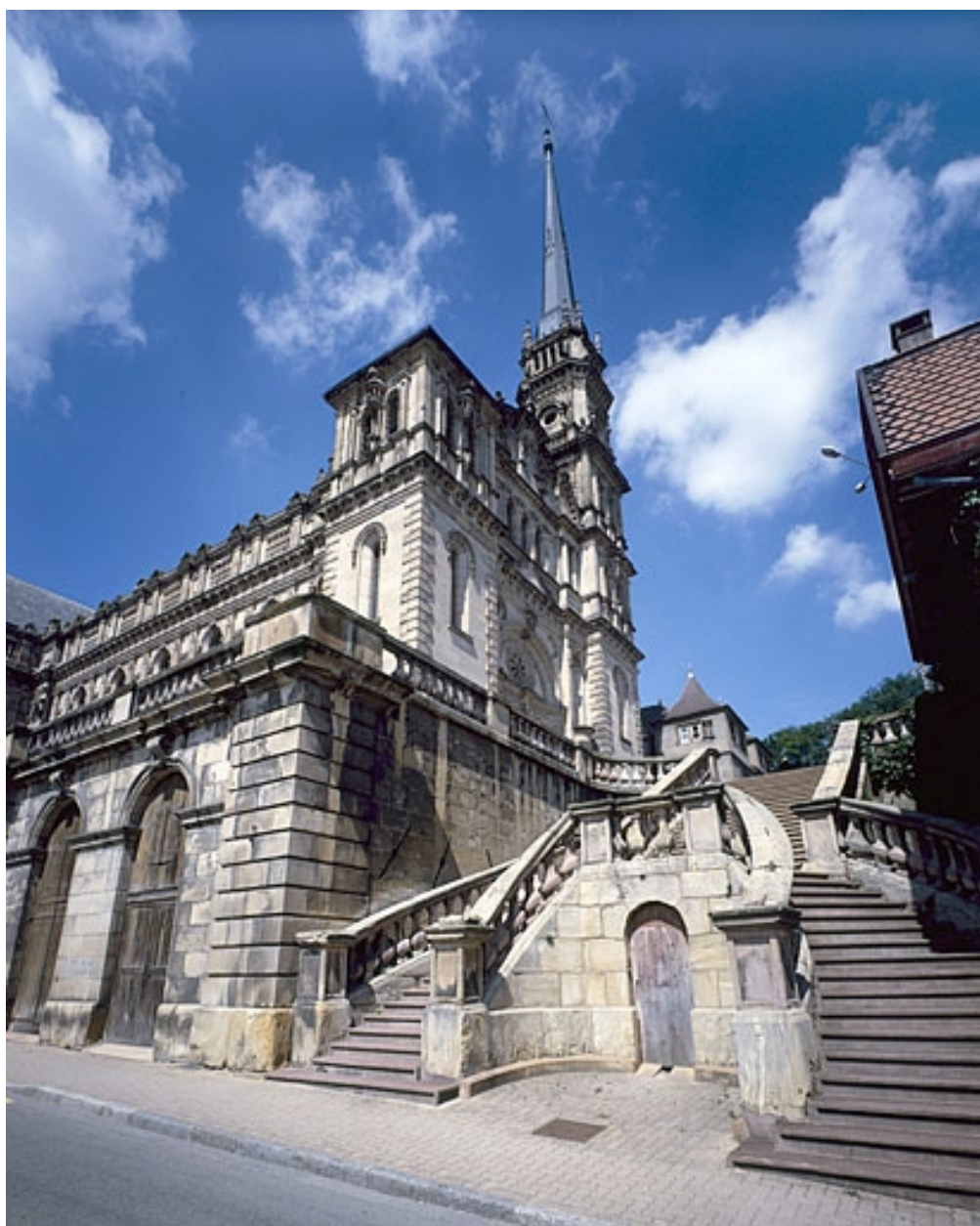
Escalier de la terrasse et façade principale.
