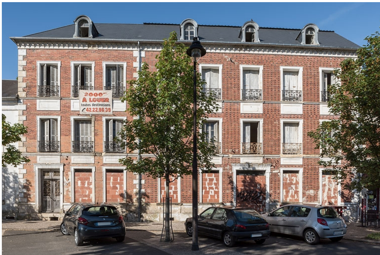
Façade de l'extension de Jules Guimard.
