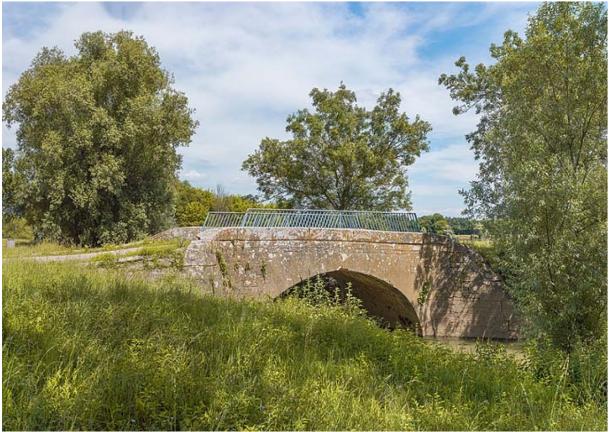
Vue d'ensemble du pont.
