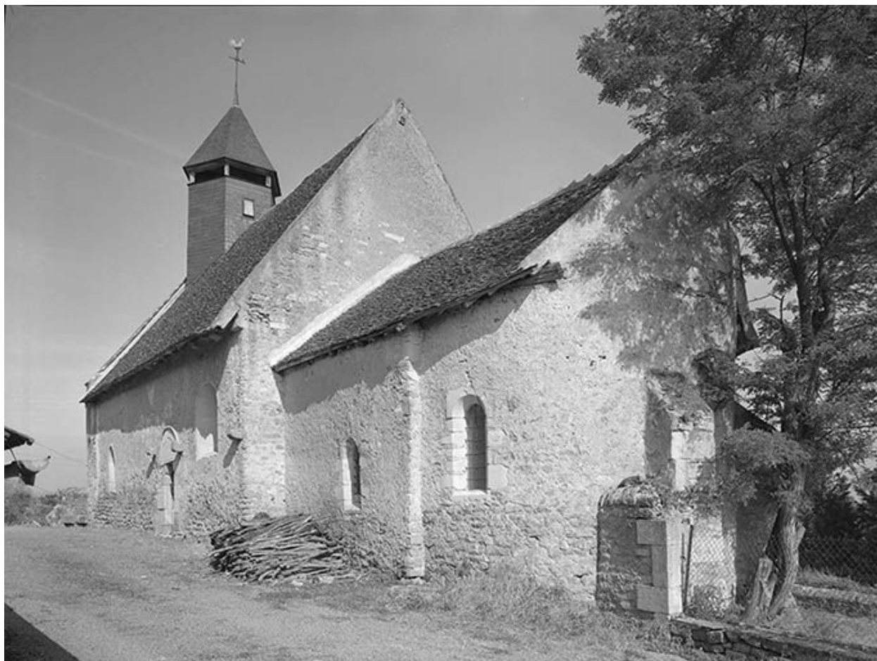
Elévation droite et abside.
