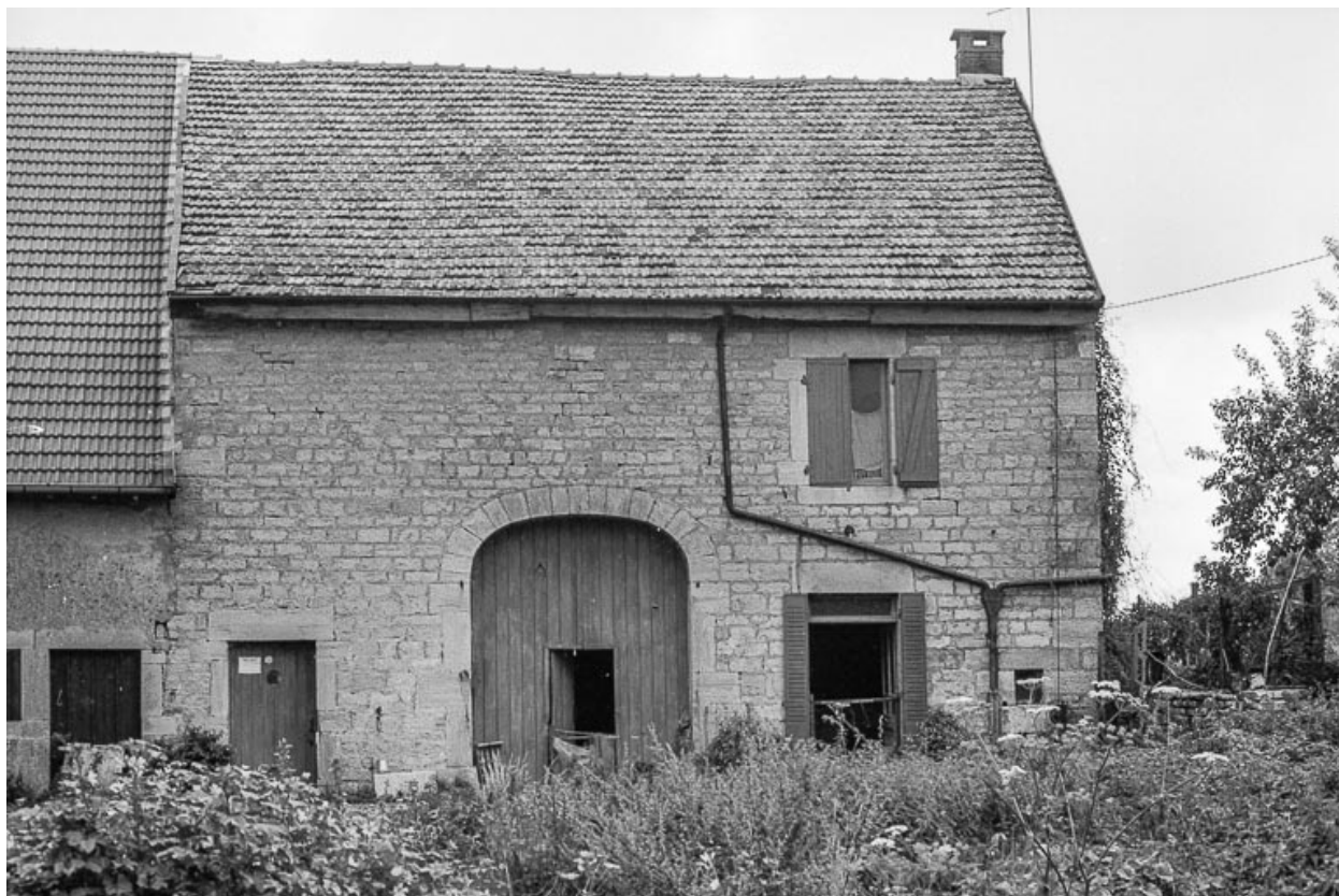
Façade antérieure : vue rapprochée.
